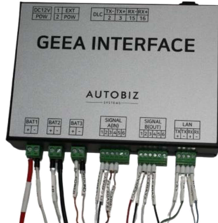
배선 연결 후
